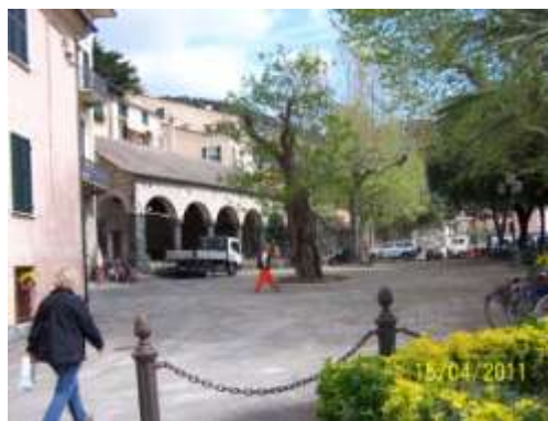
Obnovljena Loggia v Levantu
