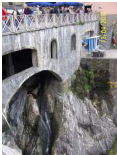
Ploščad vsidrana v skalo
